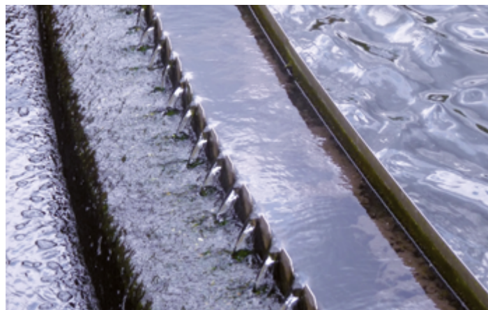
Abb. 1: Abwasserbehandlung von kommunalen und industriellen Abwässern (© DECHEMA)
