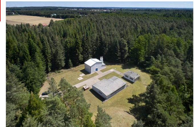
Trinkwasserwerk auf Langeoog (OOWV, oben) und in Nienburg (KWN, unten)
