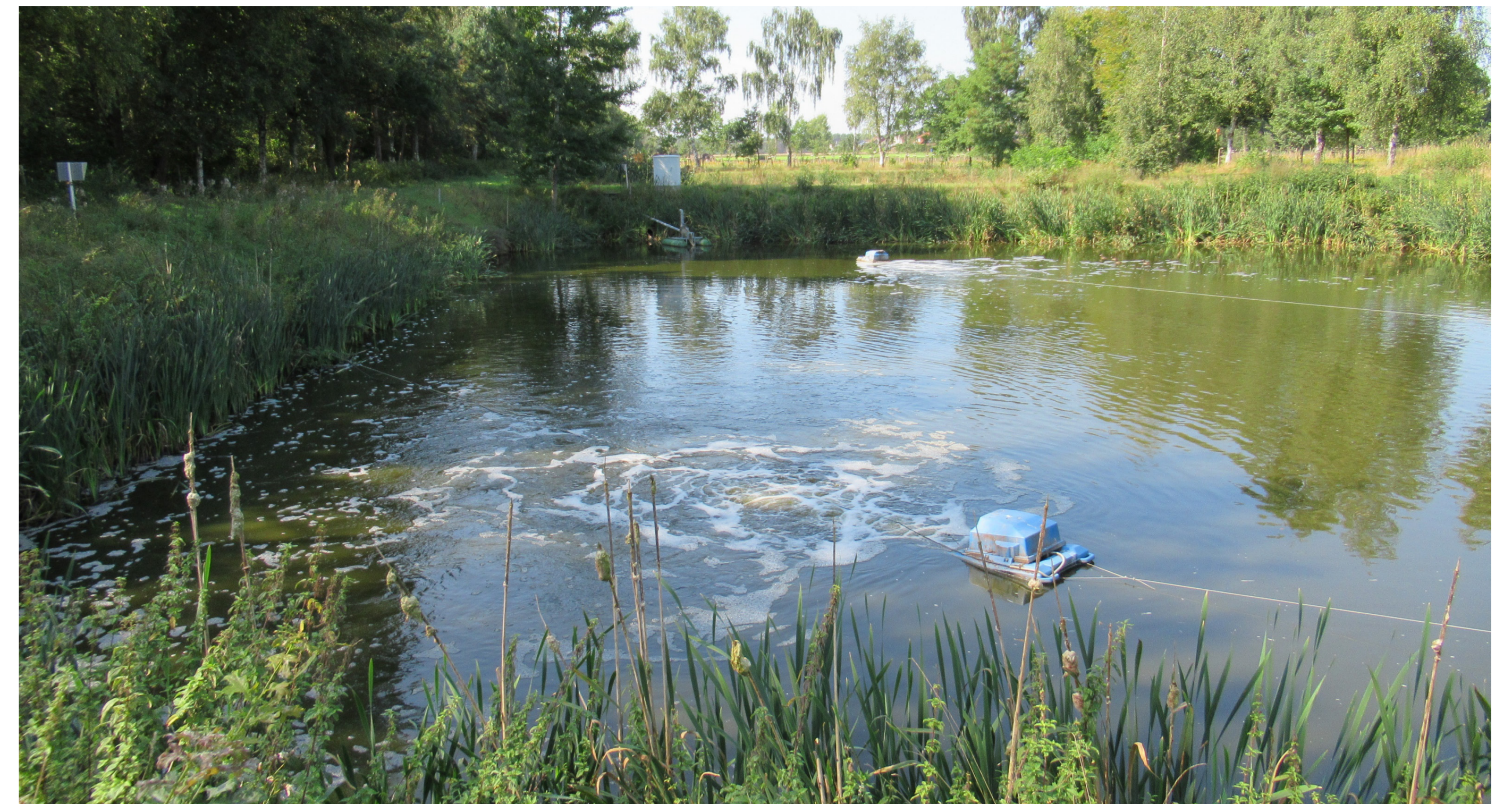
Abb. 1: Teich zwei der Teichkläranlage Weißenberge (Foto: T. Dockhorn)
